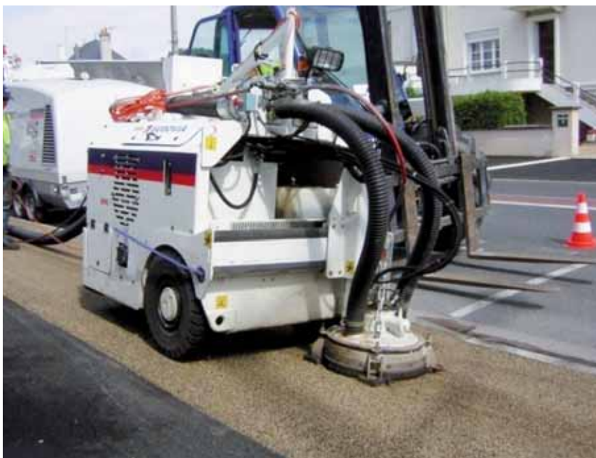
Obróbka mechaniczna – metoda wymywania
