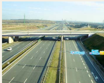
Autostrada A4: Obwodnica Gliwic, Ruda Śląska–Katowice
