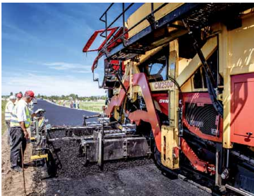
Rozkładarka gąsienicowa wraz z modulem do warstw kompaktowych
