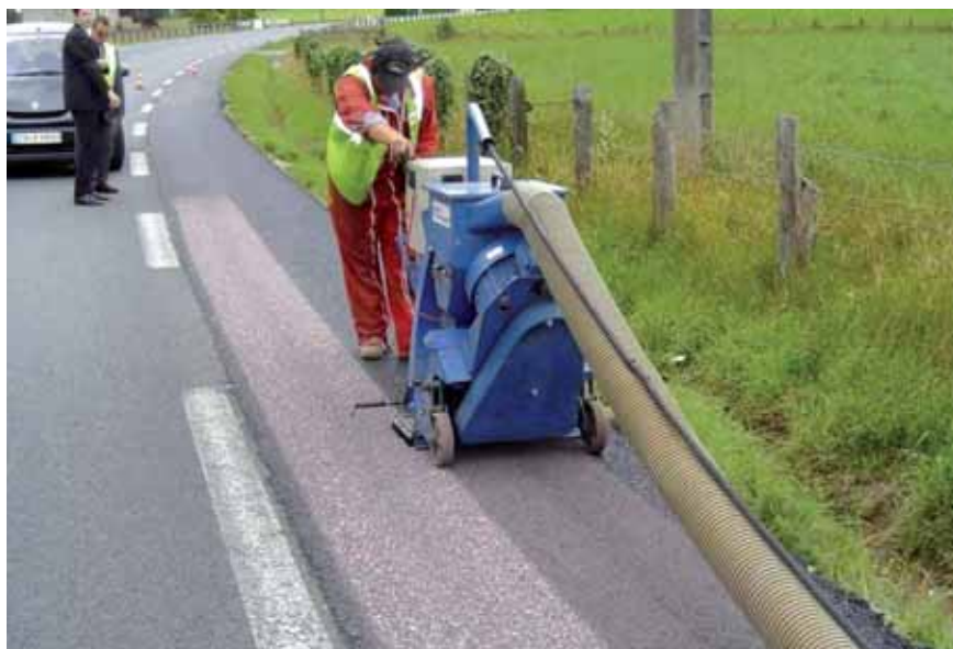
Obróbka mechaniczna – metoda piaskowania
